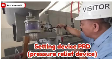
Setting piranti komponen PRD (Pressure relief device)
