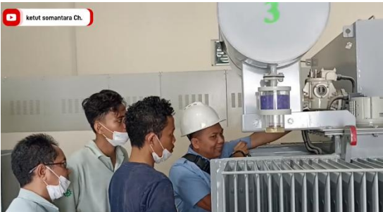
Gambar 5 : Seting komponen pengaman trafo
