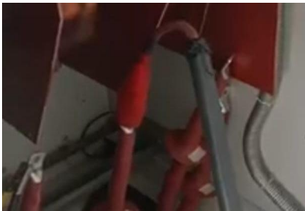
Gambar 2. Koneksi pengujian DC Hipot pada terminasi kabel tegangan menengah
